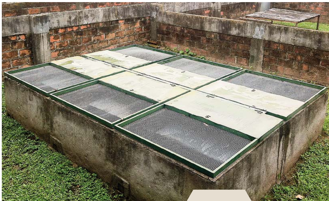
Fig. 37. Grupo de seis nidos. Las tapas están fabricadas con chapa y tela metálica.
